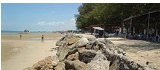
تمثل هذه الصورة جدارًا بحريًا نموذجيًا يُستخدم لمنع تآكل السواحل والسيطرة عليه
